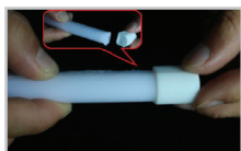
На конец ленты установите глухую заглушку. Используйте герметик для гидроизоляции соединения
