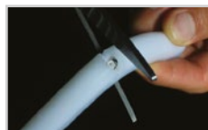
Используя ножницы или нож, сделайте надрез на лицевой поверхности оболочки
